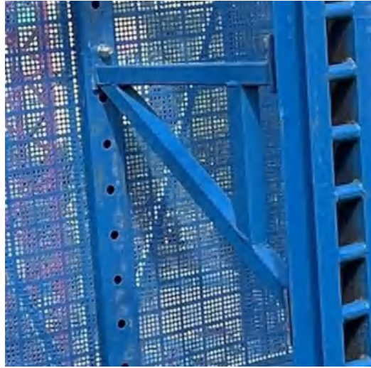
Triangular truss 三角桁架
